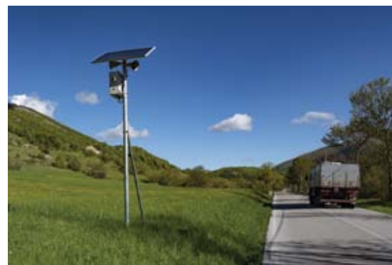
Impianto di prevenzione incidenti montato nel progetto
